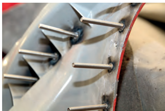
Aufgeschweißte Edelstahlbolzen zum Ausziehen der Nieten.
