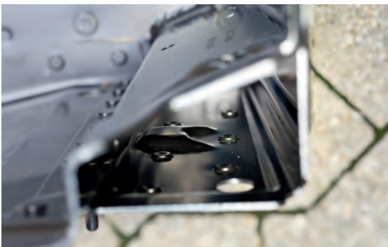
Die Innenseite der gelösten Nietverbindung blieb dabei absolut unbeschädigt.
